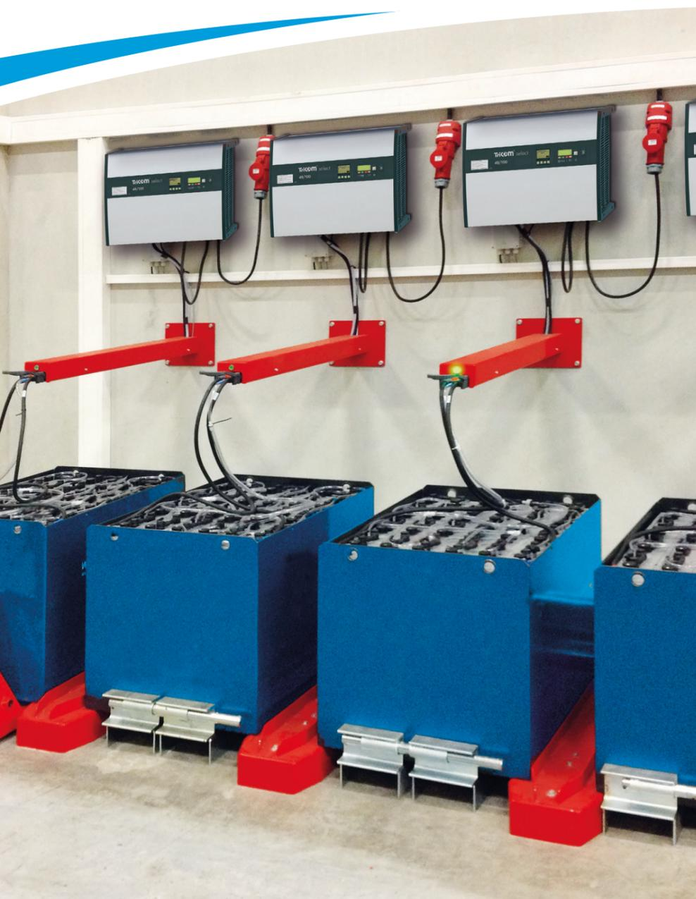
Installation von den offenen Batterieräumen - Ladestationen. Wenn der Anleger über keinen freien Ort für einen Batterieraum verfügt, empfiehlt Airtel den Einsatz von modularen Ladestationen. Sie ermöglichen eine freie Auswahl des Batterieladungsortes bei der Aufrechterhaltung der erforderlichen Standards und Einschränkungen. Diese Option bietet die Ausbaumöglichkeiten bei der zunehmenden Menge von Traktionsbatterien
